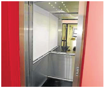
Das Gebäude mit einer Fläche von 803 Quadratmetern verfügt über einen modernen Aufzug.
