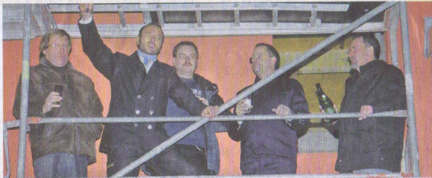
Die Offiziellen beim Verkünden des Richtspruchs.
