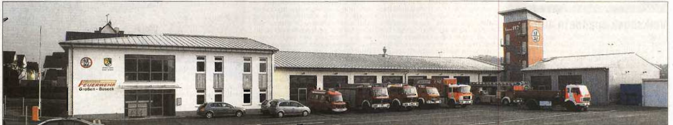
Das neue Feuerwehrgerätehaus in Großen-Buseck wird im Rahmen eines zweitägigen Festprogramms heute offiziell seiner Bestimmung übergeben.
